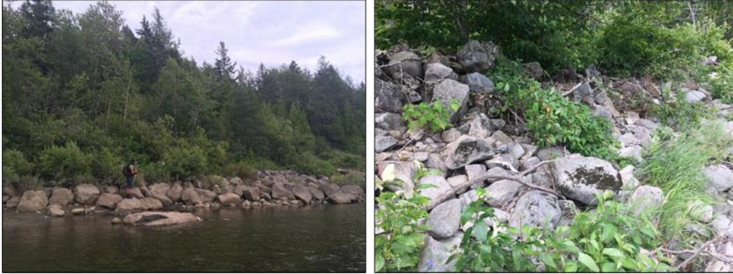
Figure 17 : Exemple d'énrochements sur les berges
